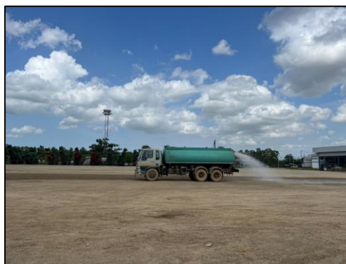
รูปที่ 2-3 การฉีดพรมน้ำ บริเวณพื้นที่ก่อสร้าง
